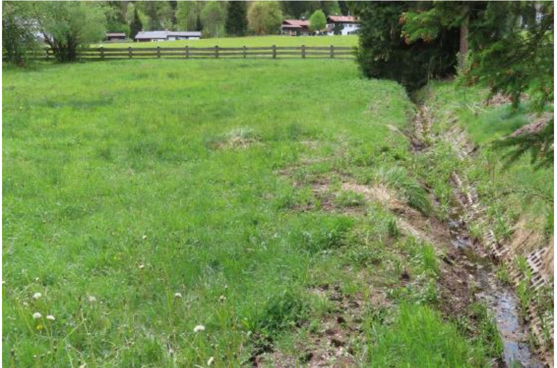
Abb. 8, befestigter Wassergraben auf Flurstück 1622/1, ohne Maßstab, Quelle: Vegetationskundliche Begutachtung, Dr. Schober, Gesellschaft für Landschaftsplanung, 05/2024
