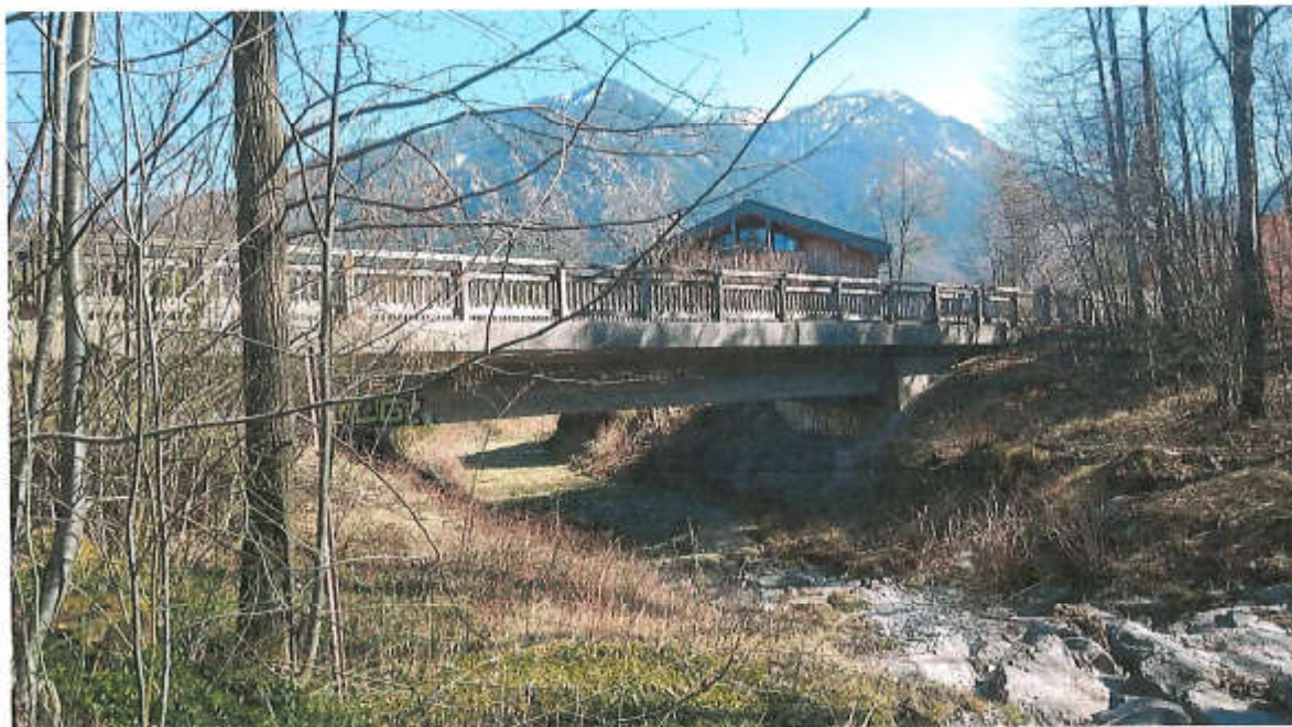
Abbildung 8: Südöstlicher Teilbereich des Plangebiet am Dürnbach im Markt Schliersee, LKr. Miesbach; Blick in Richtung Südosten (Mühl 06.04.2020=)
