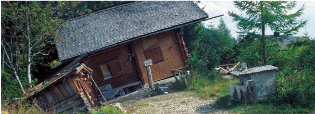
Durch Rutschung schief gestelltes Ferienhaus
