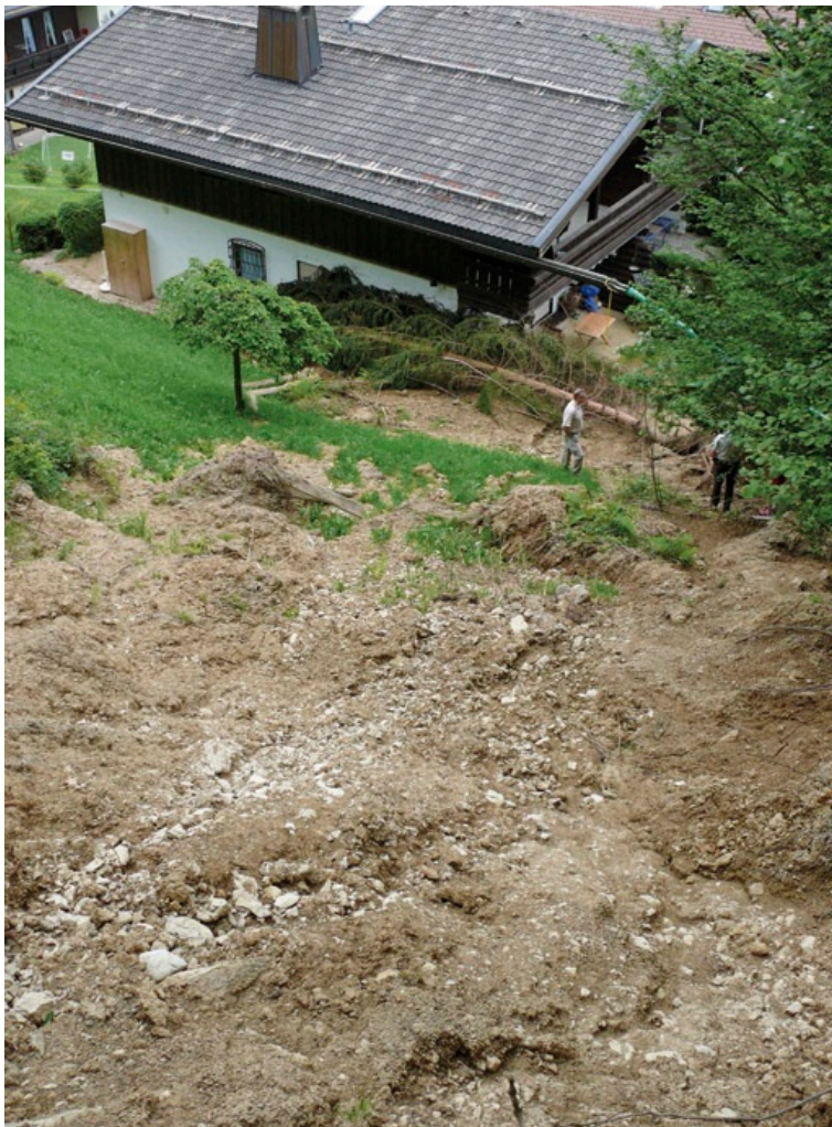
Hanganbruch an einem Haus
